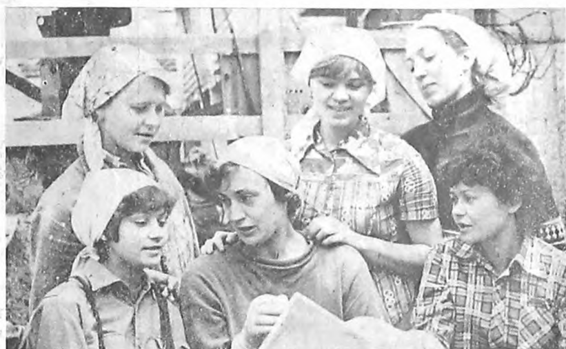
Небольшая передышка. Нужно обсудить важные производственные дела. На снимке: бригада Л. Волокитной из ССО «Эллада» на строительстве жилого дома.
