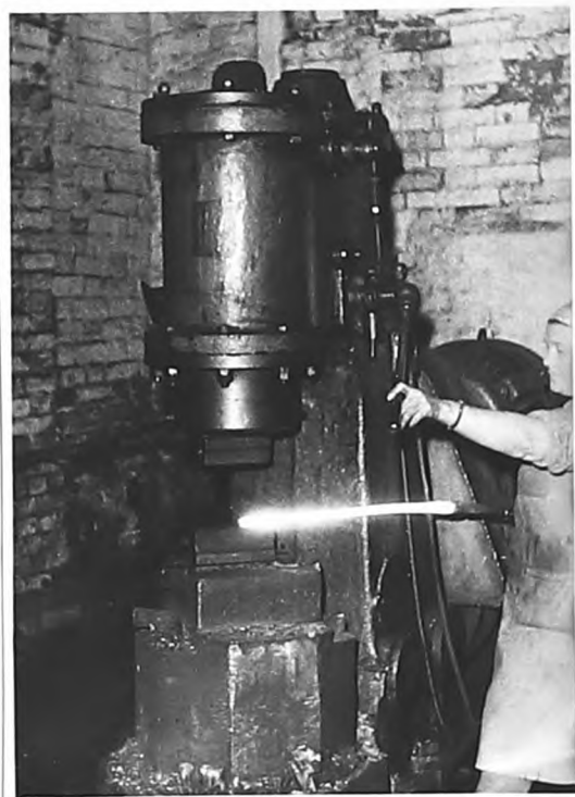
Рис.1. Отковка кованцев на пневматическом молоте Беше
