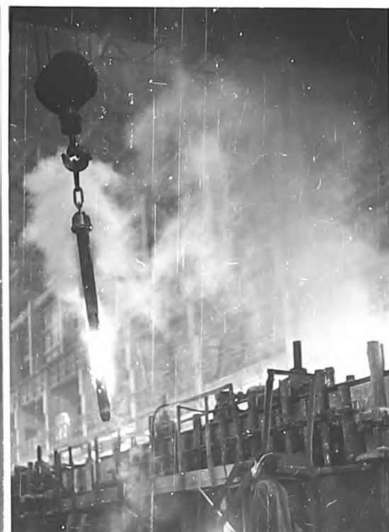
Рис.9 - Извлечение шпирей из анода электролизера с верхним подводом тока.
