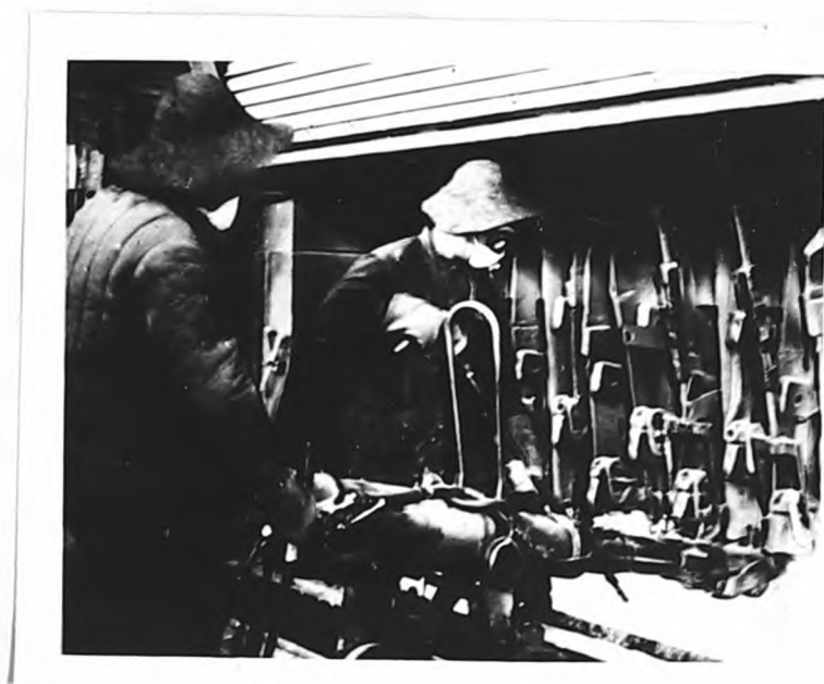
Рис.7 - Извлечение штирей из анода электролизера с боковым подводом тока.
