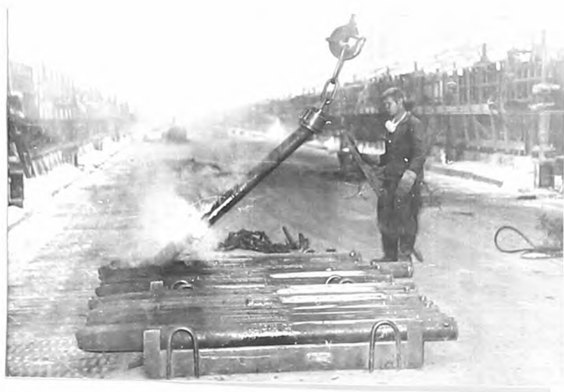
Рис. 10 - Укладка извлеченных штирей на полдон в проходе корпуса.
