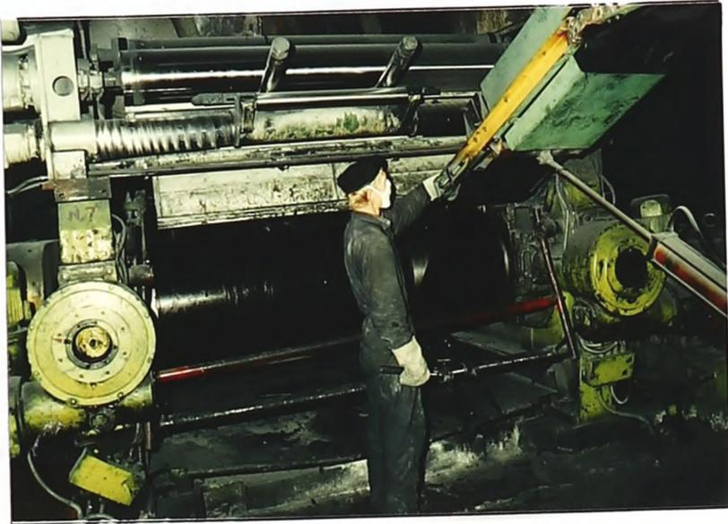
Рис. 3.5. Рабочее место вальцовщика – подрезка ленты сырой резины
