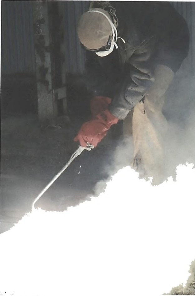
Рисунок 13. Рабочее место газорезчика участка газовой резки отходов.
